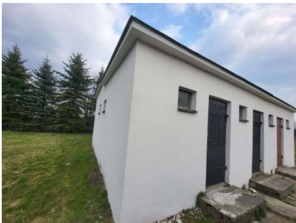
6. Remont budynku gospodarczego w miejscowości Zakrzewo Kopijki kwota 11.000,00 zł.
